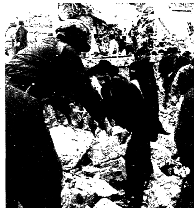
Si scava tra le macerie alla ricerca di vittime e superstiti
