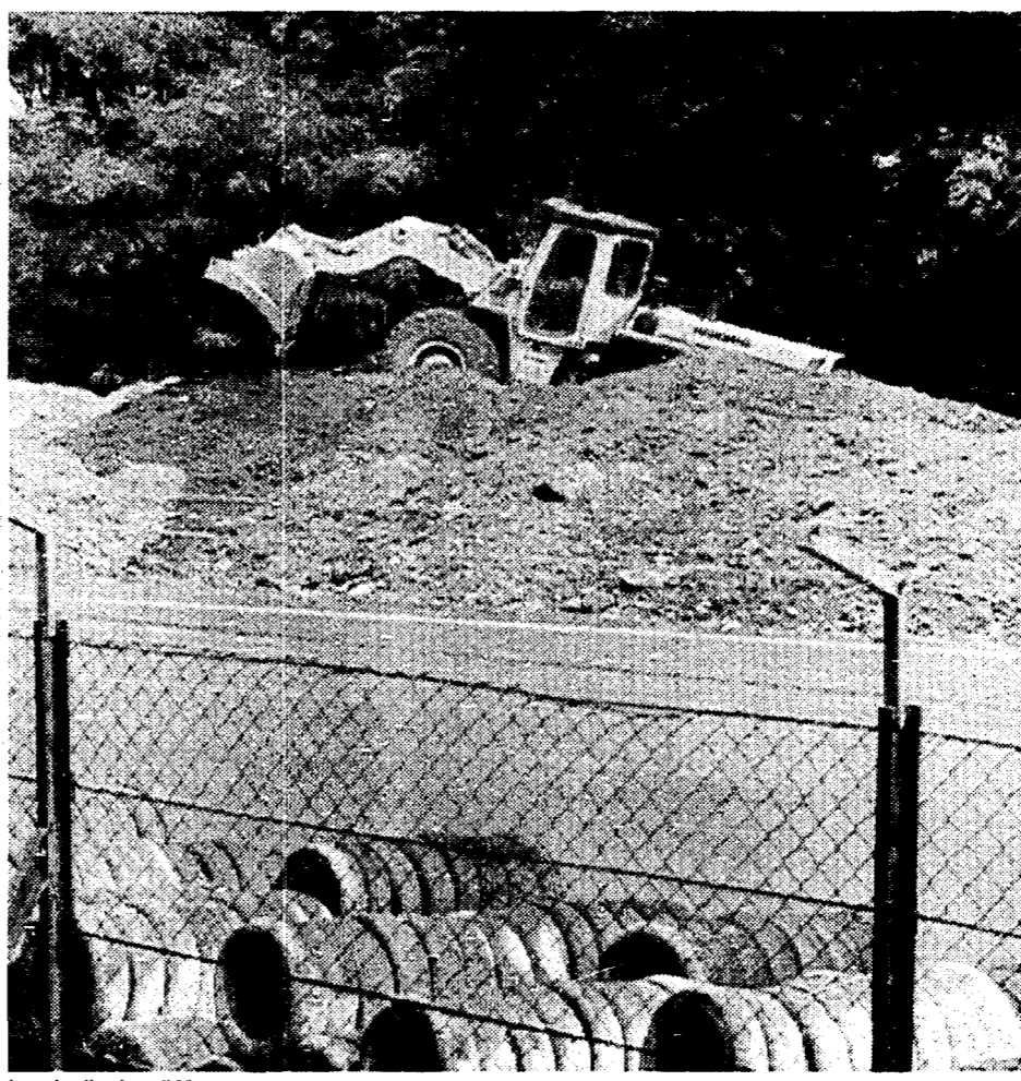
Lavori sulla pista di Monza
