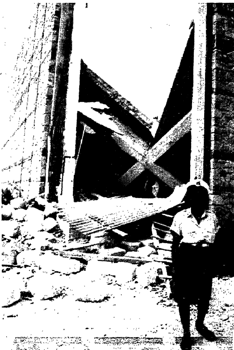
Quello che resta della chiesa madre di Gibellina già danneggiata dal terremoto del '68
