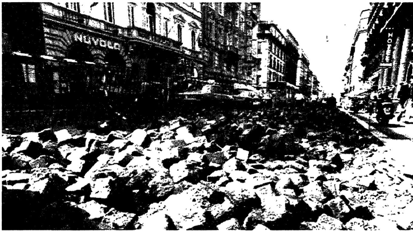
I lavori di sistemazione della pavimentazione di via Nazionale
