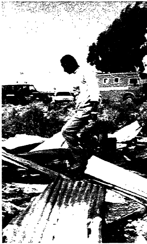
Tra le macerie dopo l'incendio
