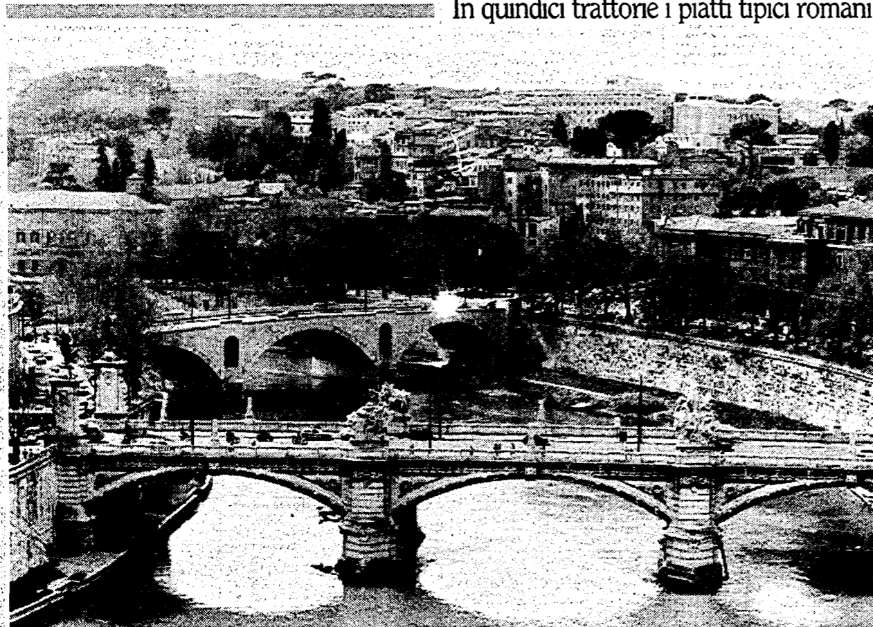
Ponte Vittorio Emanuele e ponte Principe Amedeo
