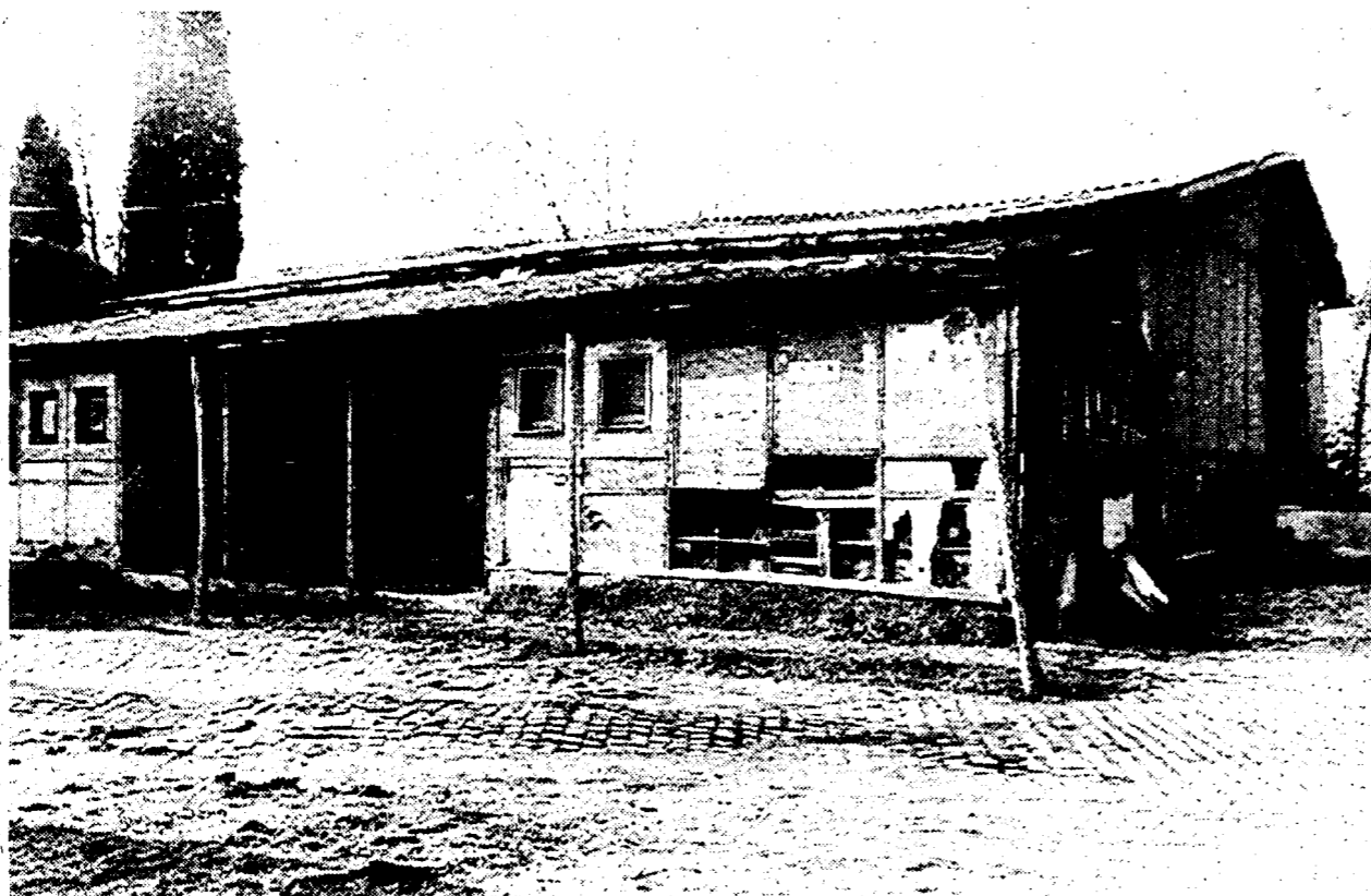
Il degrado del rimessaggio delle attrezzature nello stadio comunale dell'Acquacetosa. Sotto l'ingresso dell'impianto sportivo
