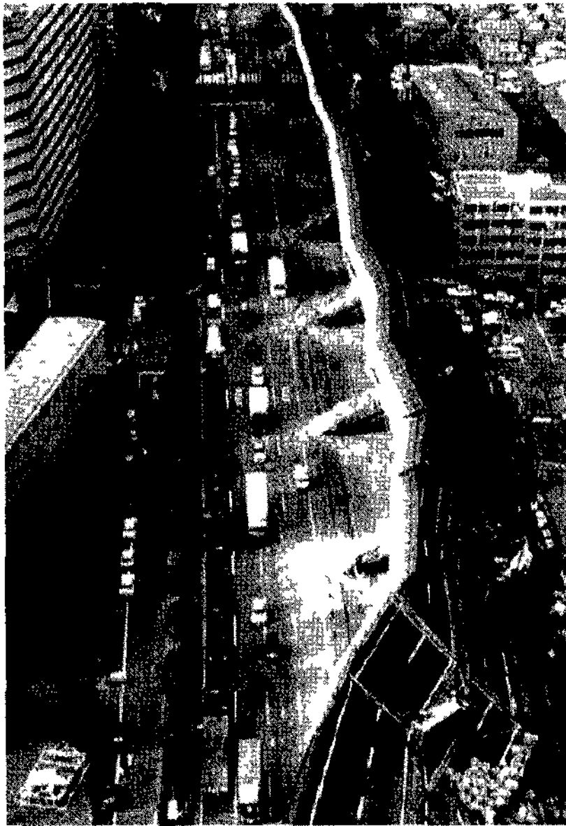
La sopraelevata divelta dopo il terremoto a Nishinomiya
