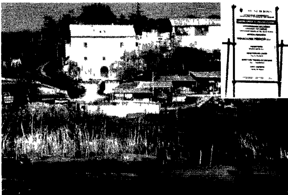
Casale e Grotta Perfetta. In alto a destra il cartello di inizio lavori di urbanizzazione
