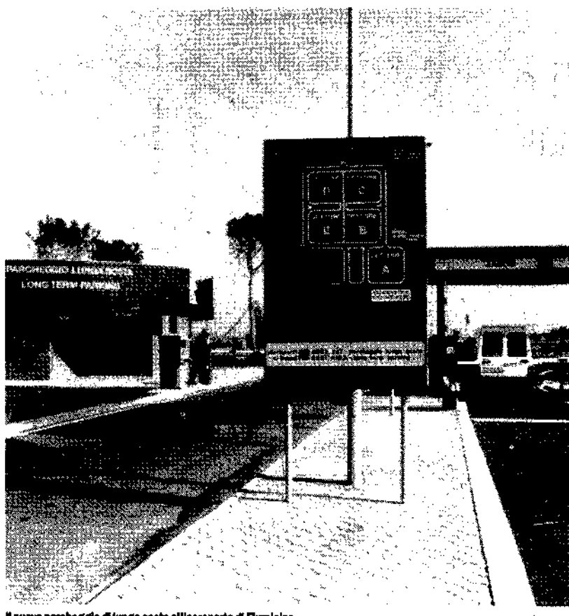
Il nuovo parcheggio di lunga sosta all'aeroporto di Fiumicino
