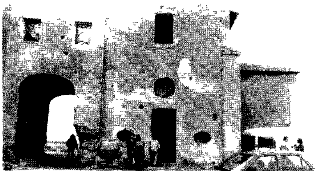
Lavori di ristrutturazione del «Castello della Falcognana»
