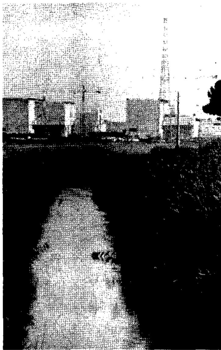
La centrale Enel di Montalto di Castro
