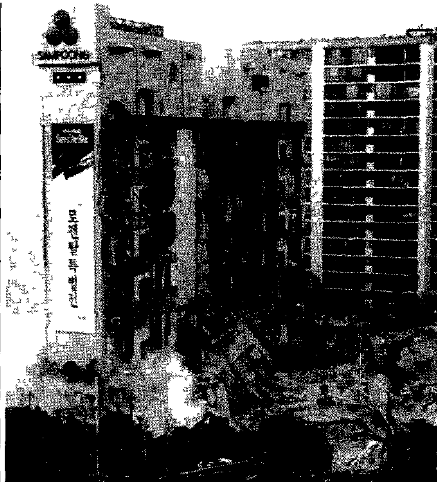
Quel che resta del grande magazzino Sampoong di Seul, distrutto da un'esplosione
