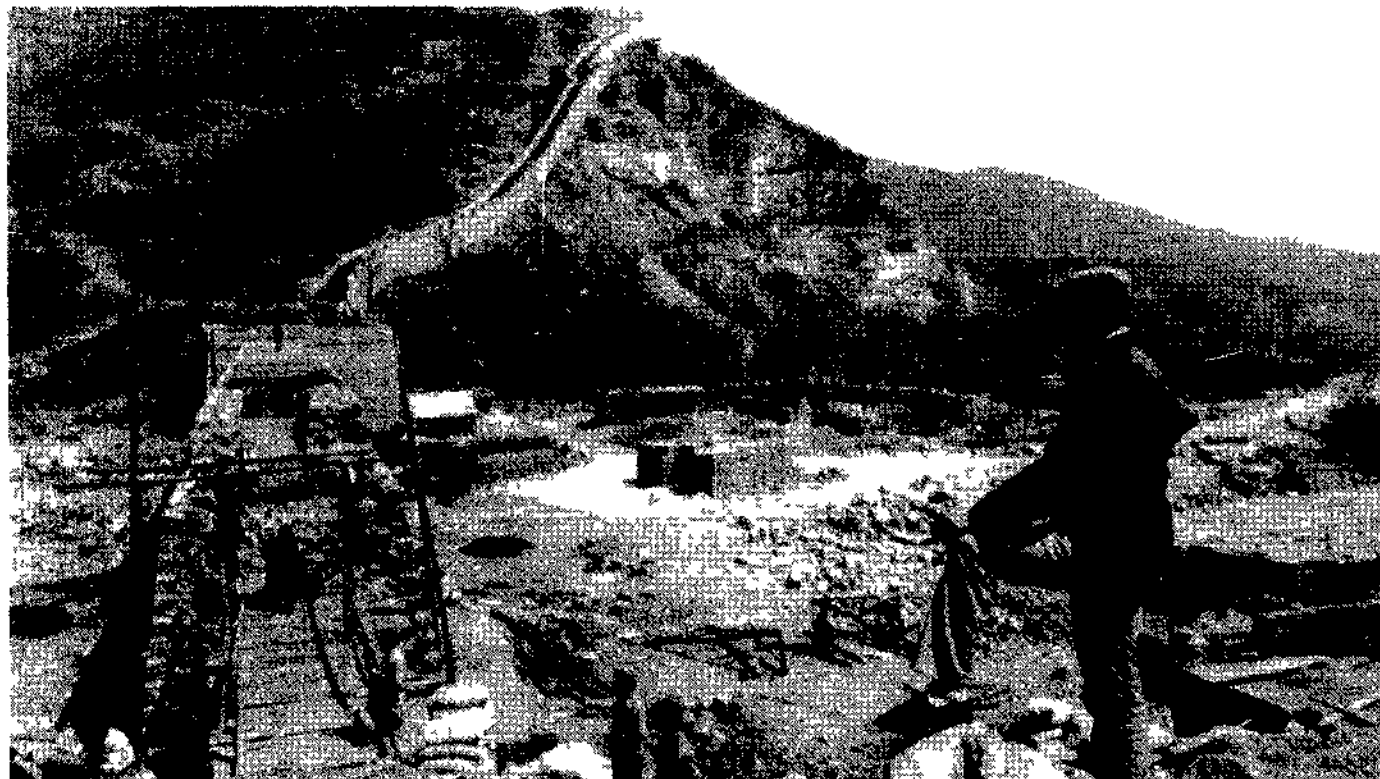
Lavori di restauro della Grande Muraglia
