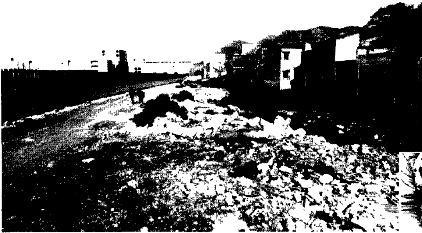
Degrado in una strada periferica di Palermo
