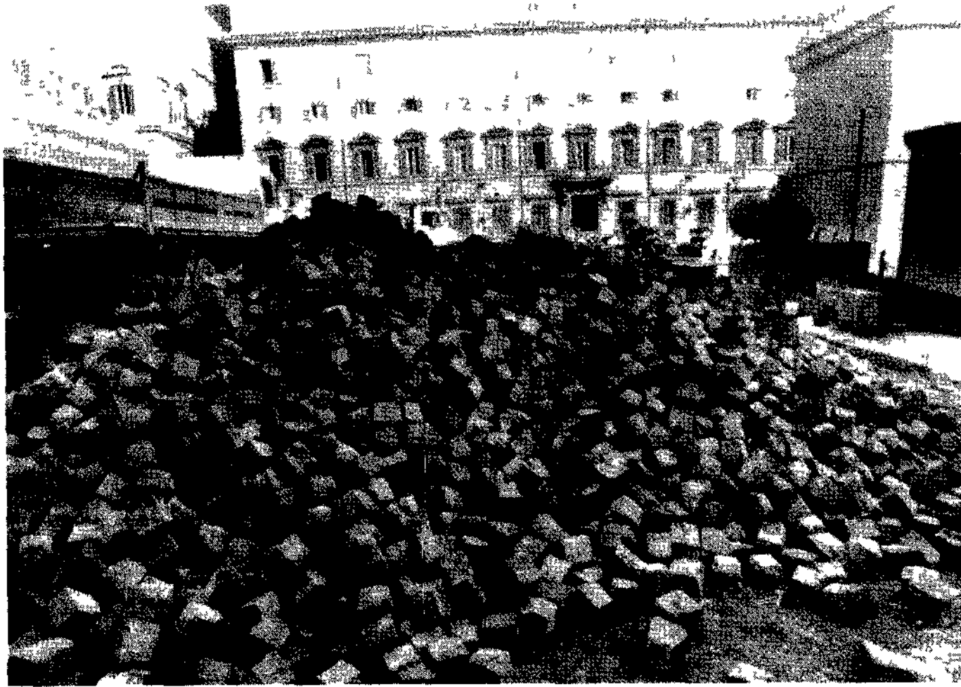
Lavori davanti Montecitorio
