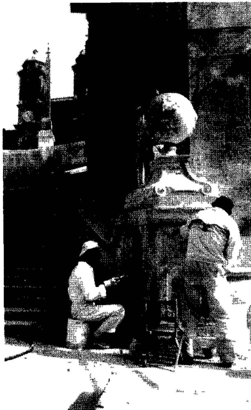
I lavori di restauro della scalinata di Trinità dei Monti
