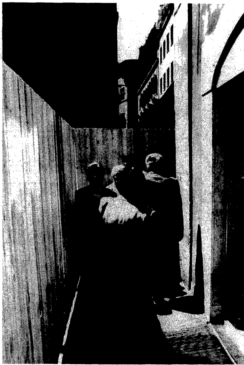
L'impalcatura per i lavori in piazza in Lucina
