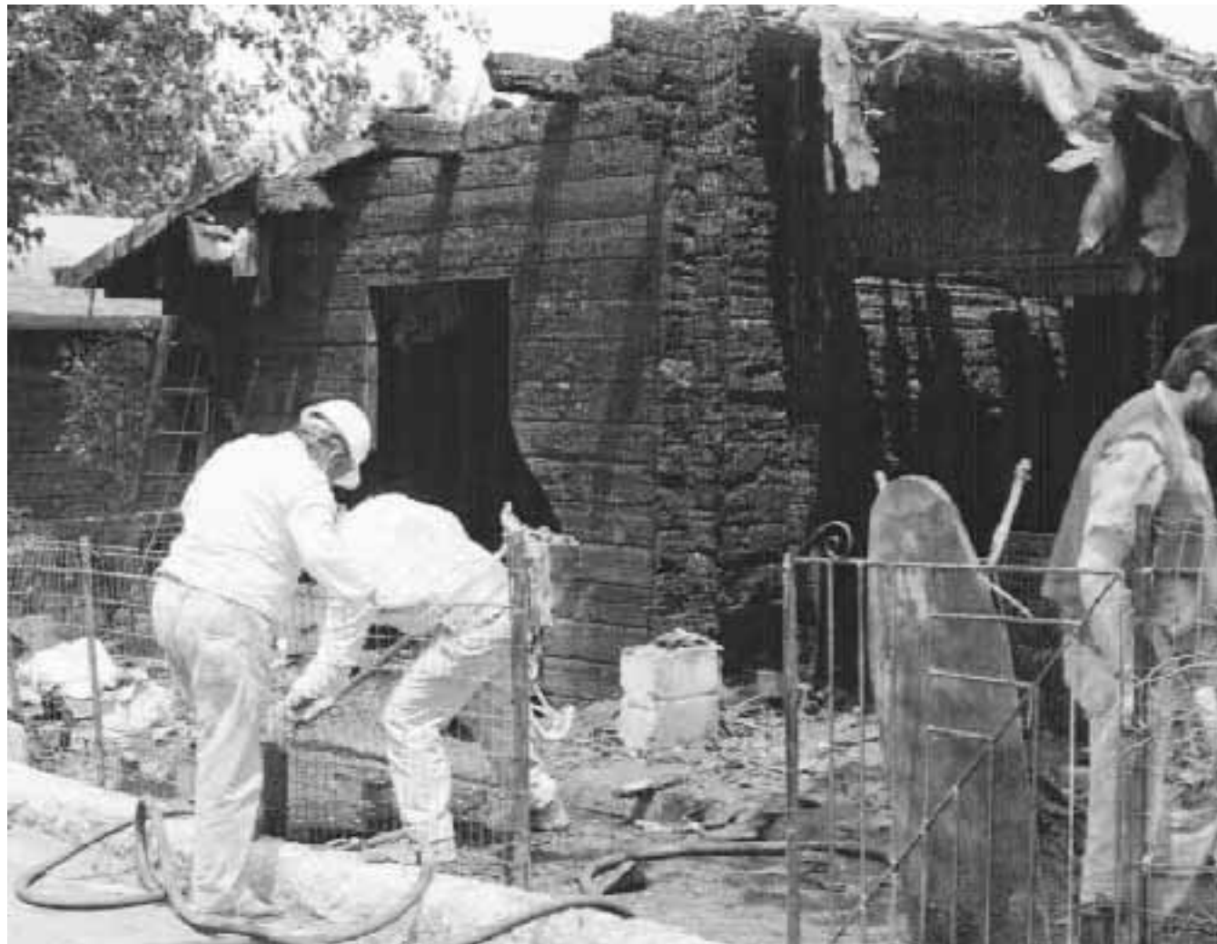
Il prefabbricato bruciato dove sono rimasti uccisi i due bambini
