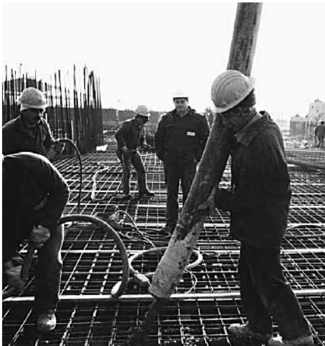
Operai edili durante la posa del cemento
