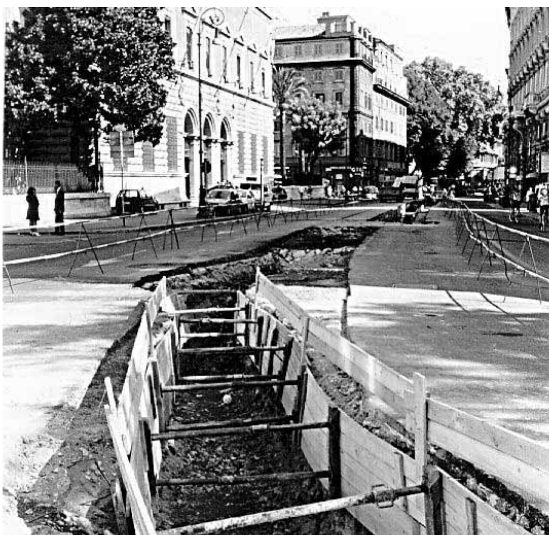
Lavori stradali in via Arenula. Sotto, Esterino Montino
