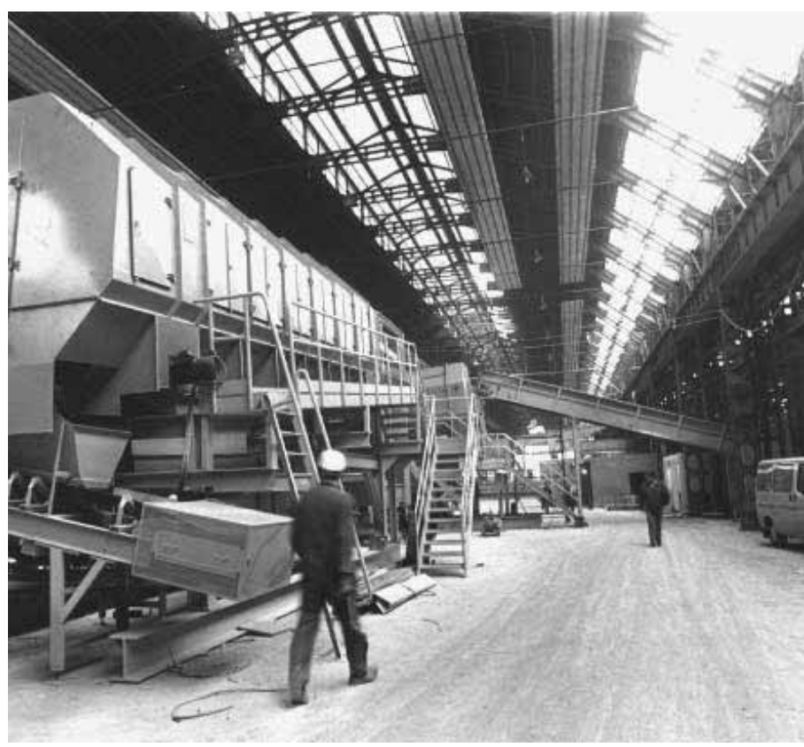
L'impianto di riciclaggio dei rifiuti all'interno della ex Maserati
