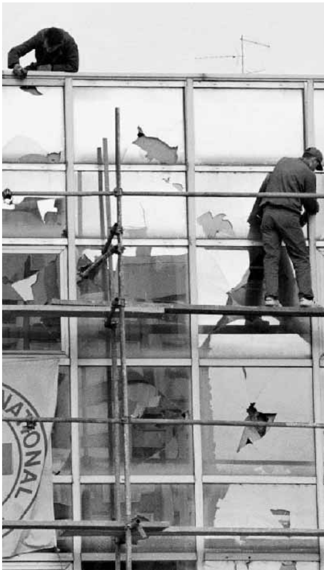
Si lavora per ripristinare il palazzo che ospita il Comitato internazionale della Croce Rossa a Sarajevo. Rikard Larma/Ap
