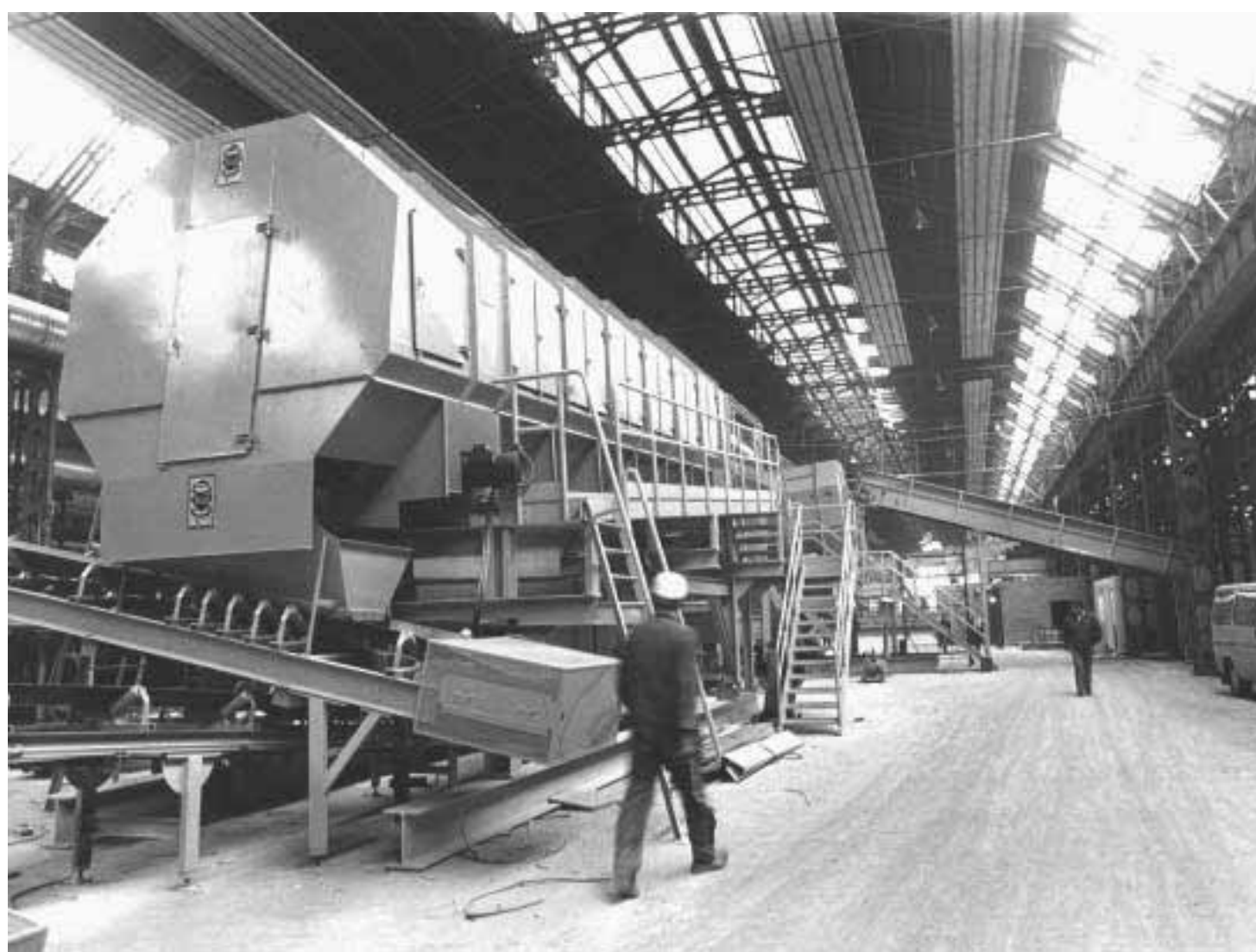
L'impianto di riciclaggio dei rifiuti all'interno della ex Maserati
