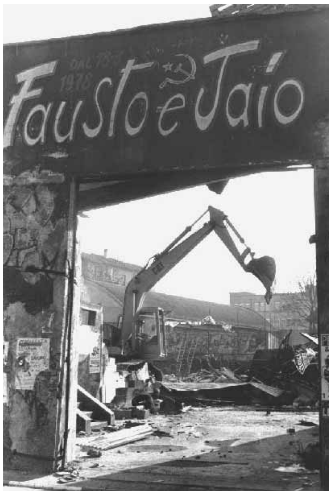
La demolizione del vecchio Leoncavallo
