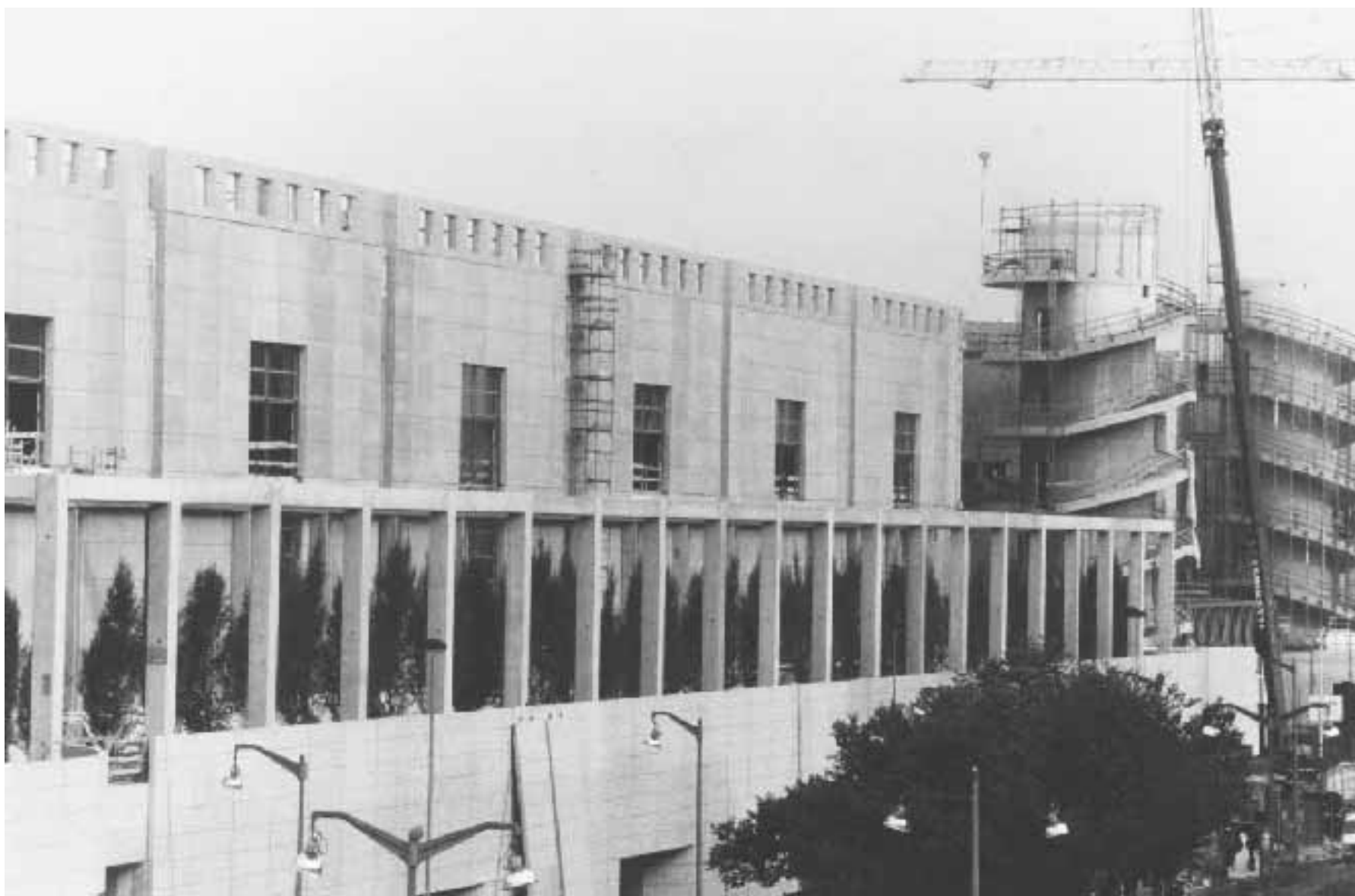
Una panoramica del cantiere al Portello Fiera
