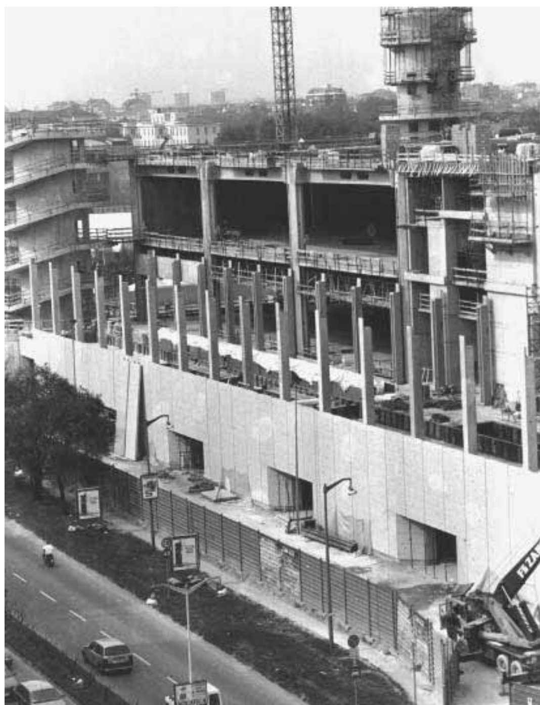
Uno scorcio del cantiere al Portello Fiera
