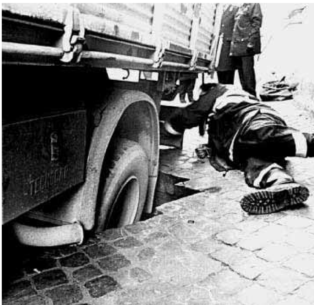
La voragine che si è aperta in via Lata
