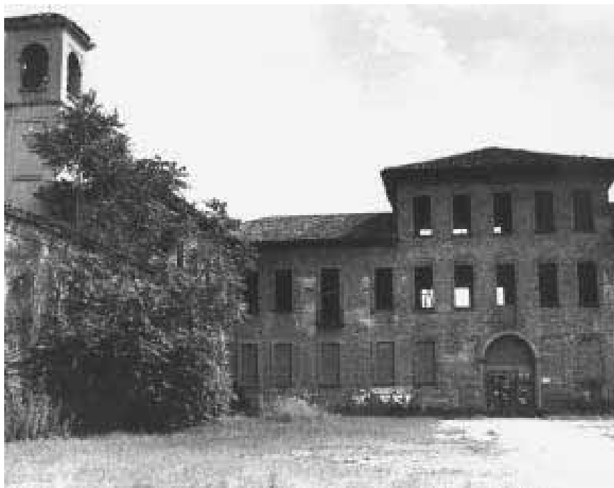
Villa Scheibler in rovina a Quarto Oggiaro
