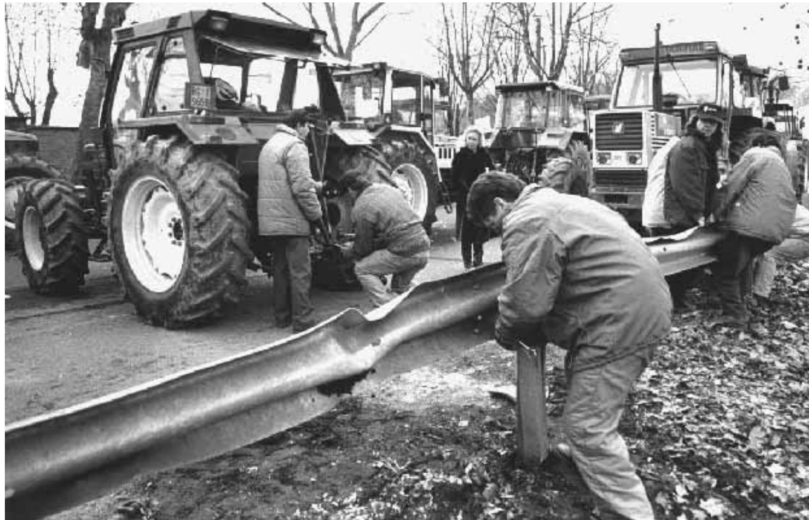
Si ripara uno dei guard-rail danneggiati dai trattori; sotto il titolo, la Rivoltana riaperta in doppio senso
