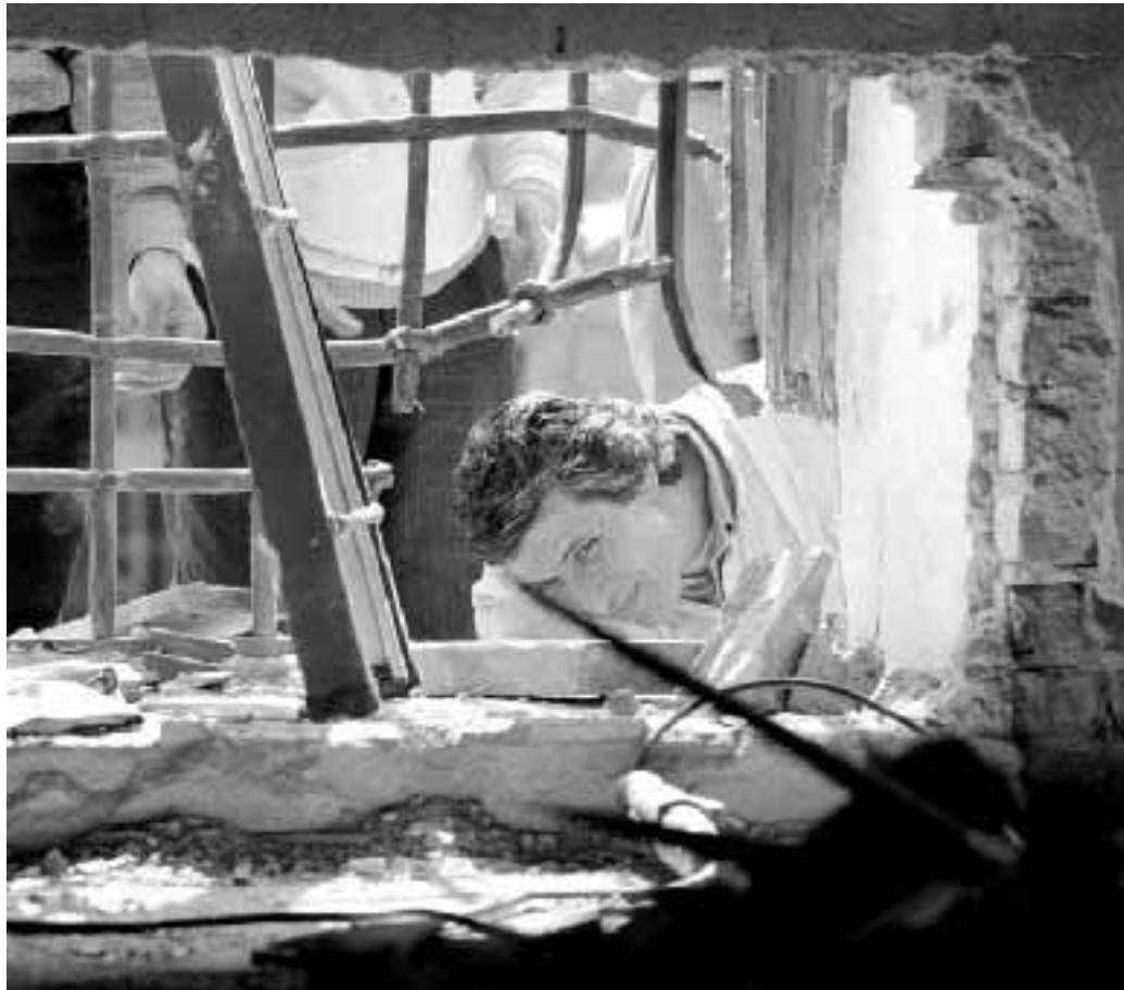
Un operaio mentre ripara i danni causati dalla bomba scoppiata palazzo Marino
