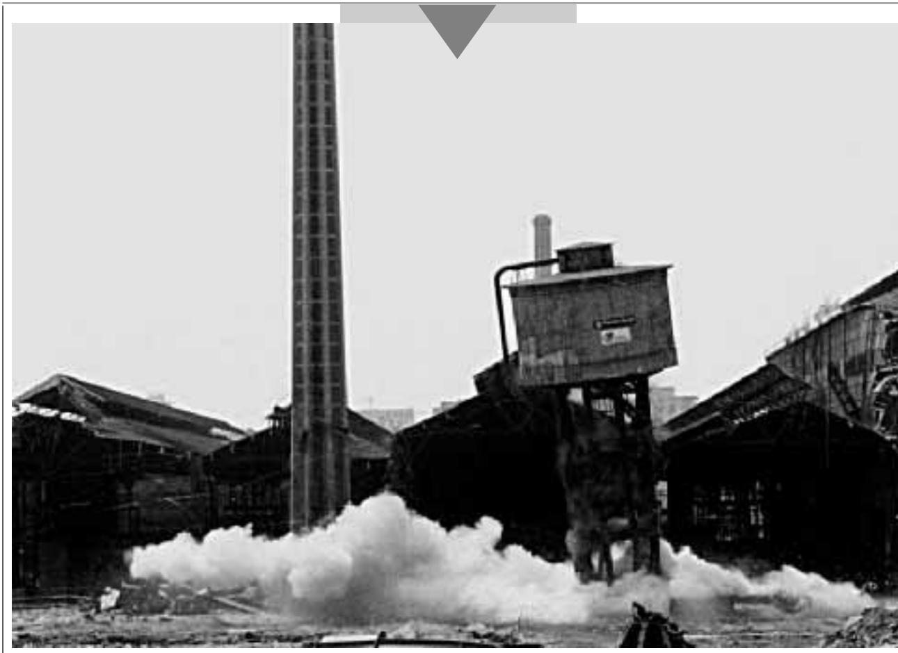
TORINO. Un momento dell'«implosione» delle ex Ferriere Fiat di Torino. La vecchia fabbrica viene demolita per costruire nel prossimo futuro un parco tecnologico.
