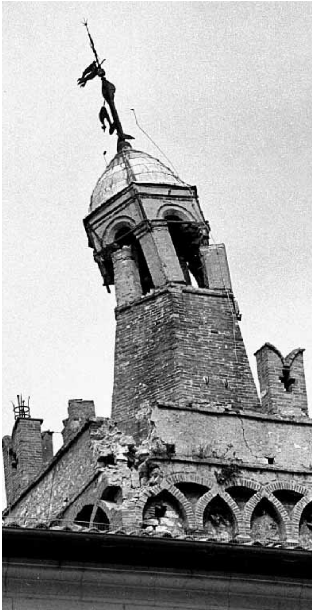
La torre del palazzo comunale di Foligno semidistrutta dalla forte scossa della scorsa notte. L. Medici/Ap
