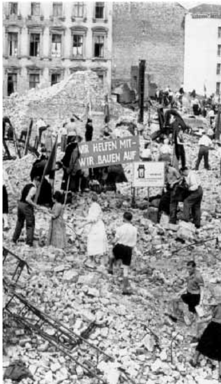
Berlino: civili al lavoro per rimuovere le macerie nel 1951
