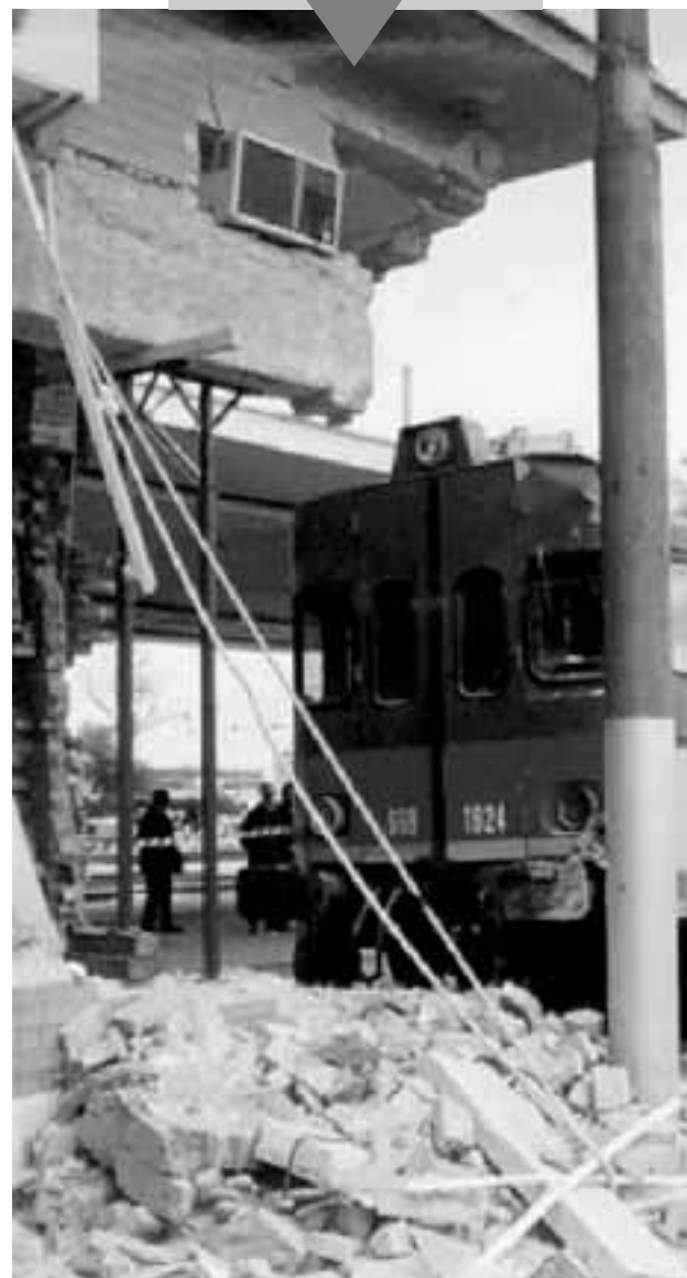
FOGGIA. Un treno «corsetta» adibito al trasporto del personale ferroviario dal deposito locomotive alla stazione centrale ieri è andato a sbattere - dopo aver travolto i respingenti alla fine del binario - contro la palazzina della centrale elettrica all'interno della stazione di Foggia. Al momento dell'incidente sulla «corsetta» c'era soltanto il macchinista, che è in istato di choc.
