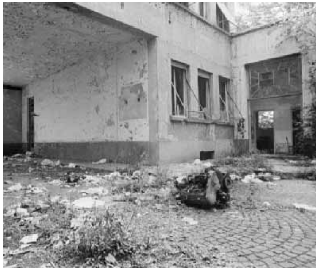
L'interno dell'ex stabilimento Marelli in via Adriano
