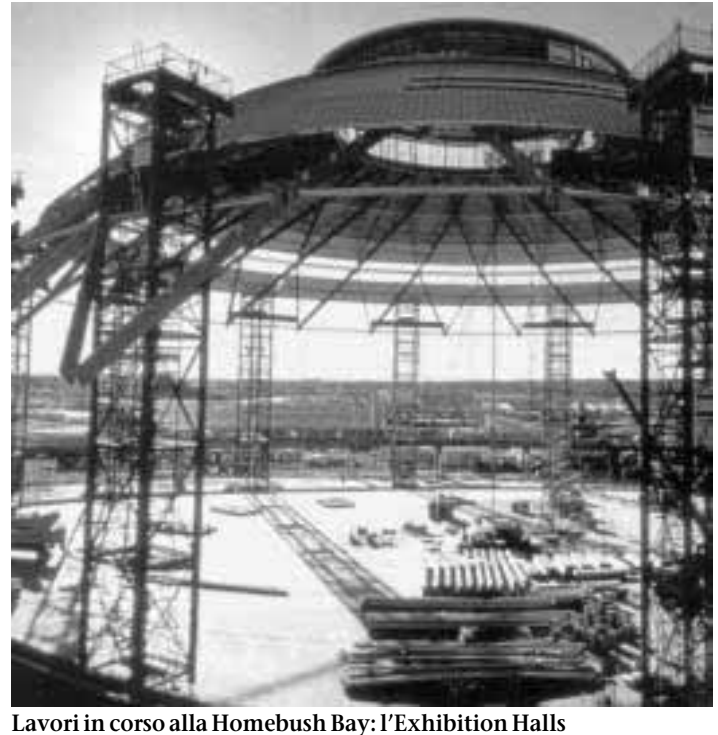
Lavori in corso alla Homebush Bay: l'Exhibition Halls
