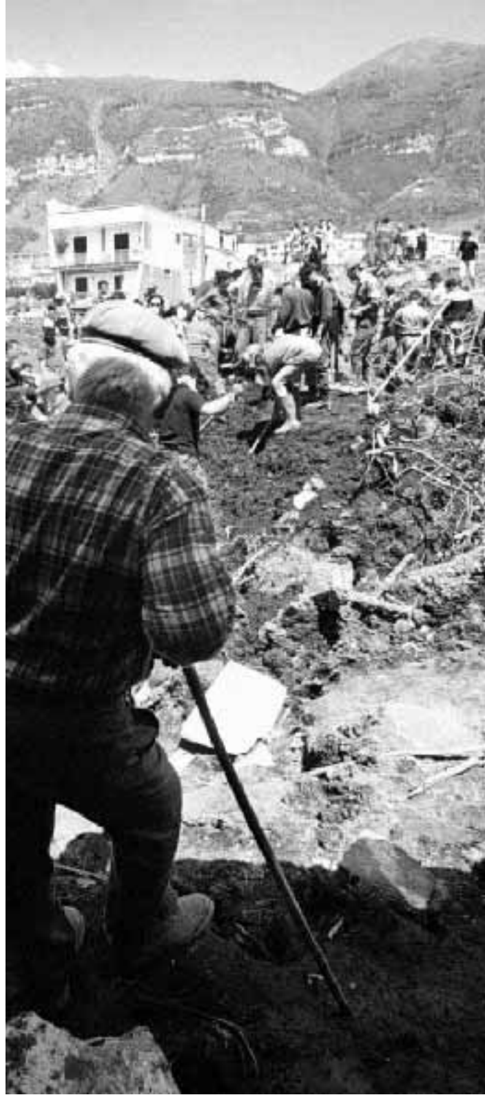
Un anziano osserva i lavori di sgombero nelle zone della frana Ap
