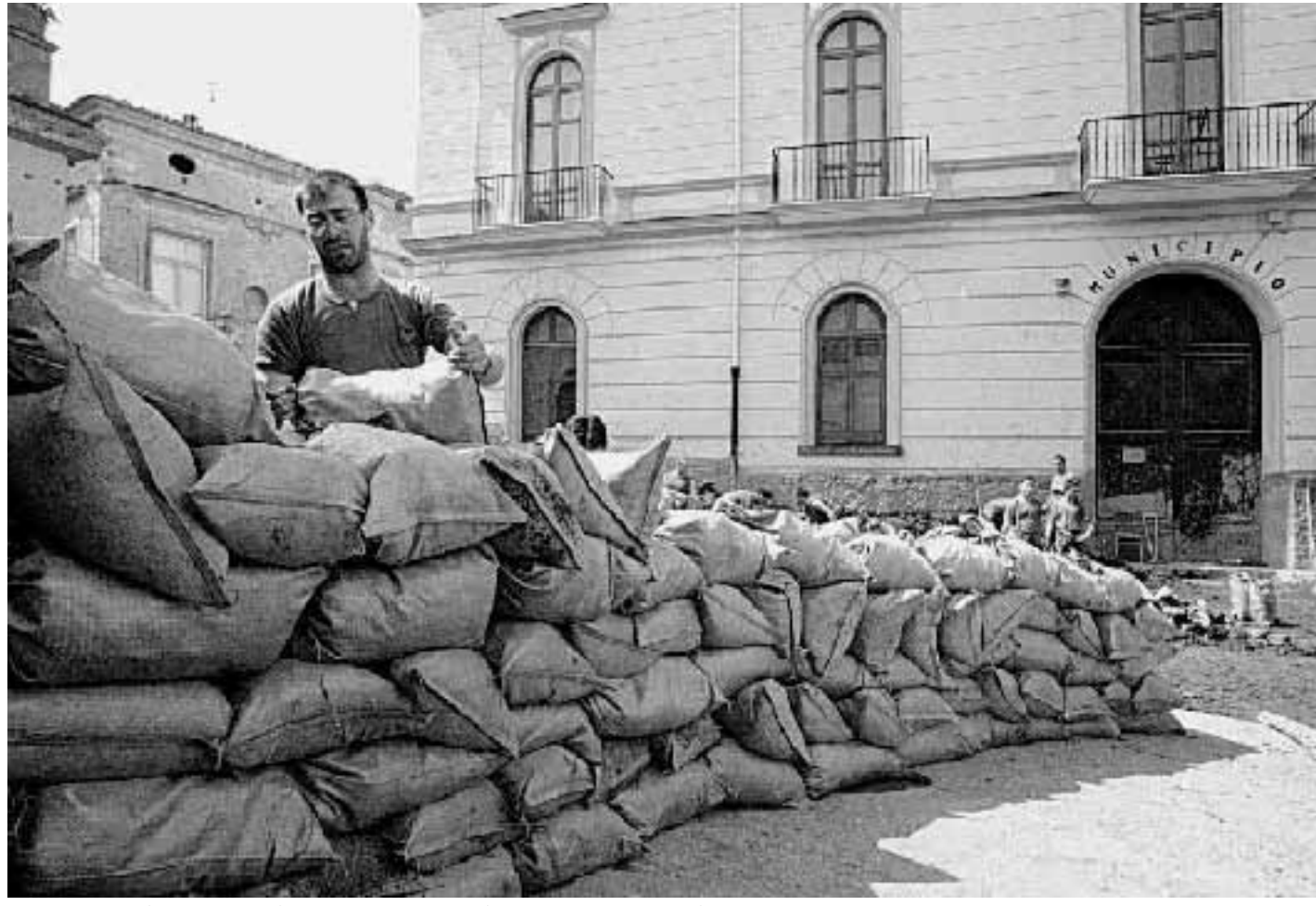
In previsione di pioggia i militari nei giorni scorsi hanno eretto muretti di contenimento
