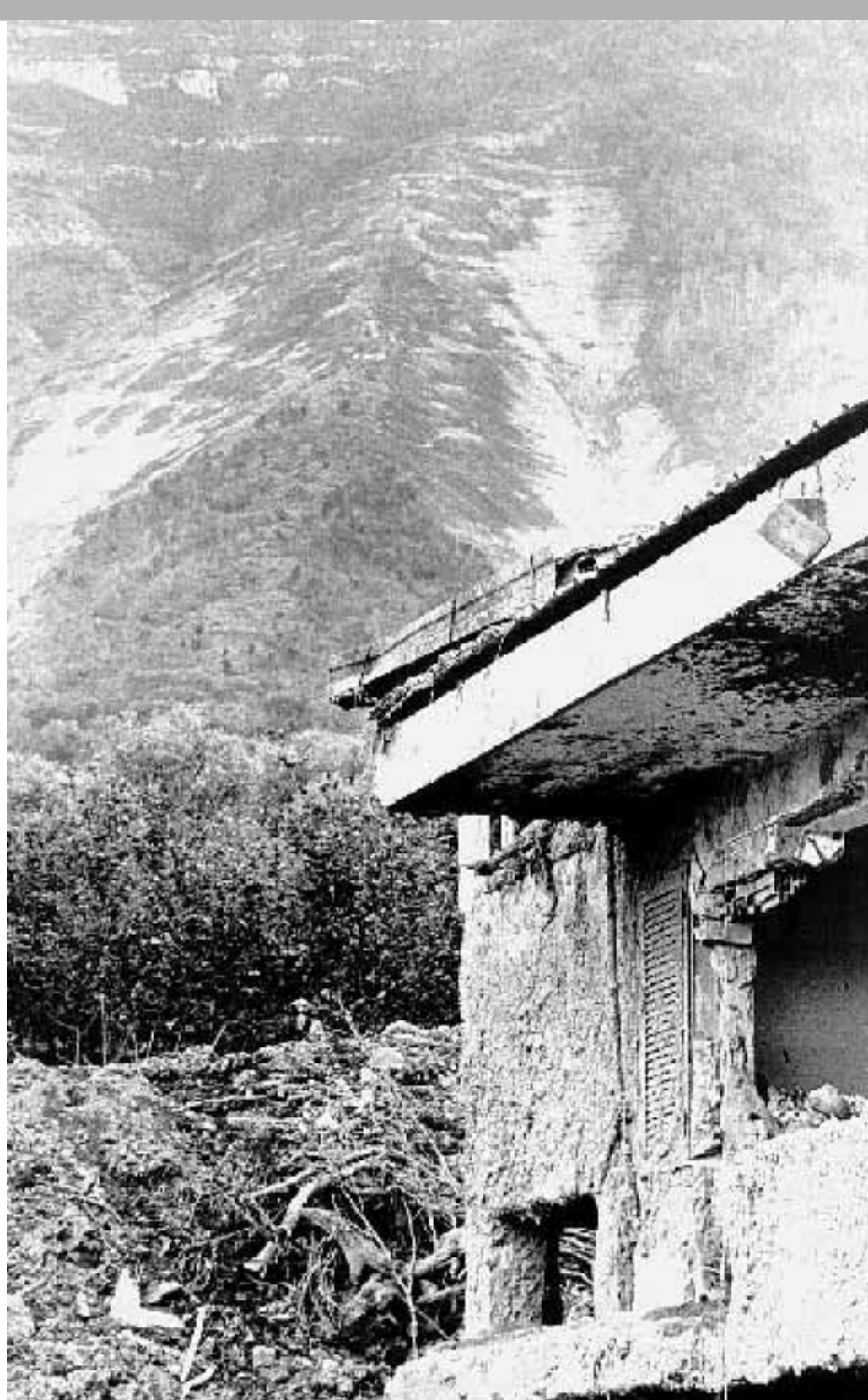
Sarno dopo la frana
