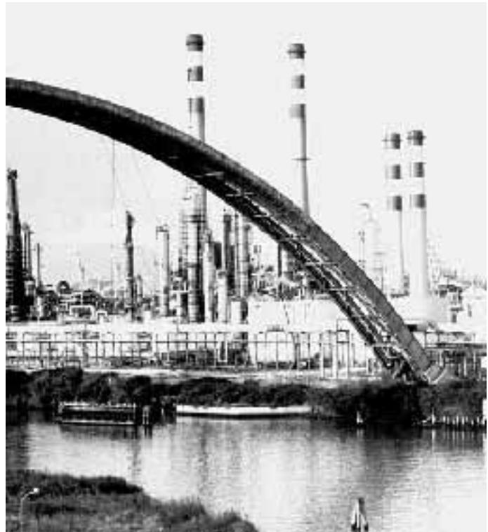
L'impianto del Petrolchimico Montedison di Porto Marghera. Errebi
