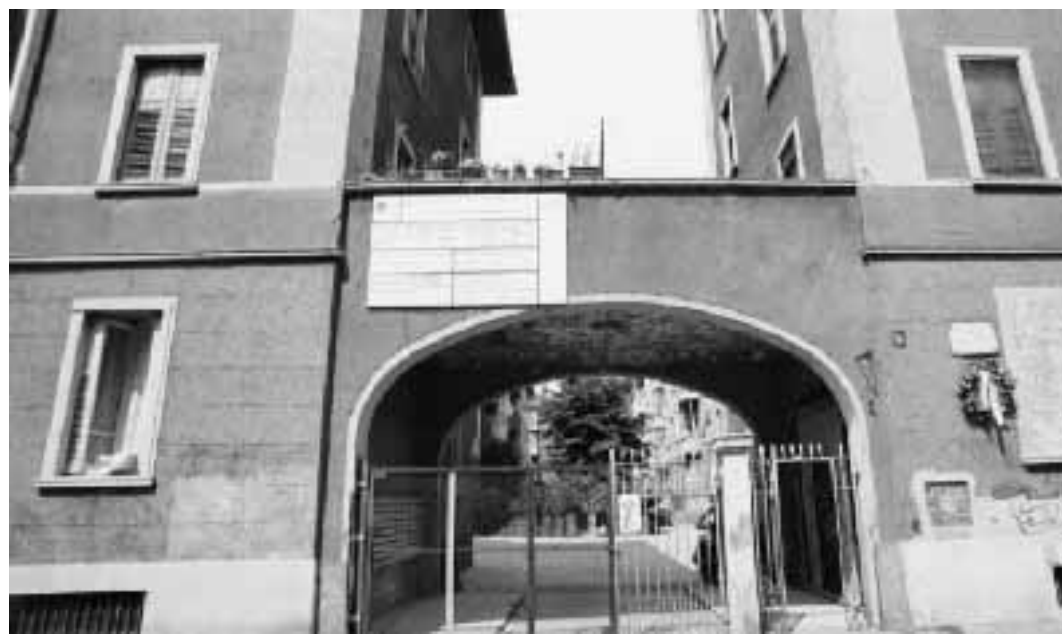
Le case dei «Labirinti» in via Barrili al quartiere Stadera
