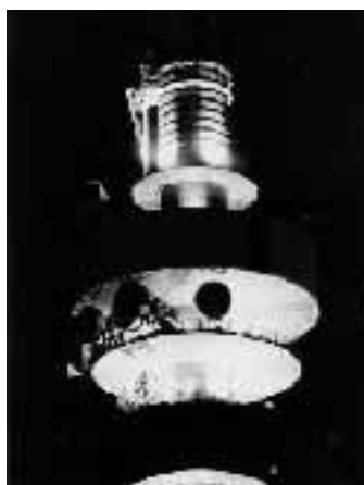
L'antenna Telecom a Roma
