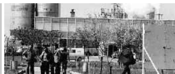
L'ex Petrolchimico di Ottana nella zona del contratto d'area
