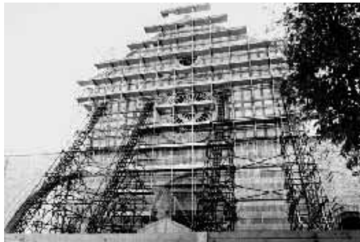
La centina in legno per la ricostruzione della volta crollata nella basilica di San Francesco. A sinistra, la facciata di Santa Chiara.
