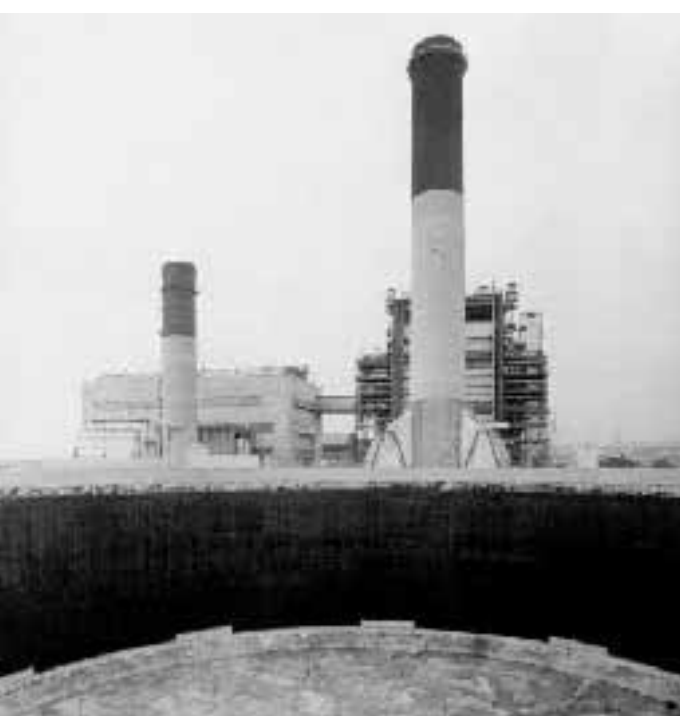
La centrale dell'Enel a Civitavecchia e sotto il ministro Edo Ronchi
