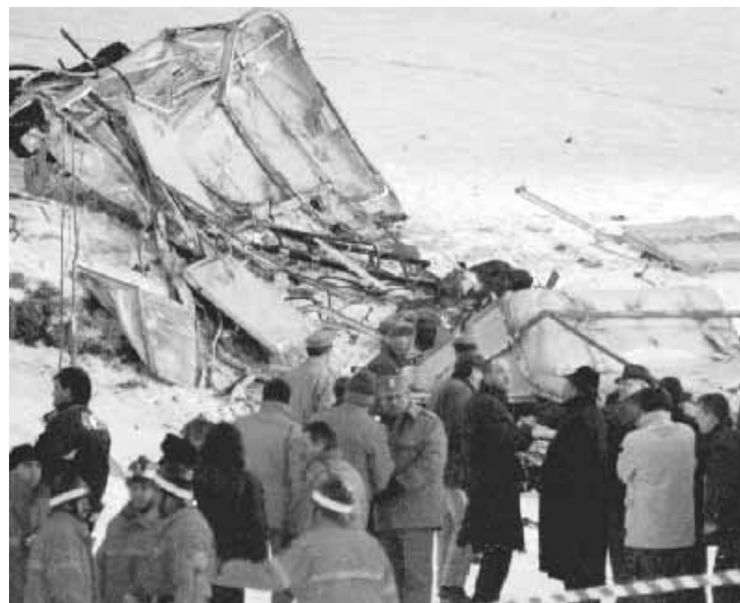
I resti della funivia del Cermis; sotto l'equipaggio dell'aereo militare Usa
