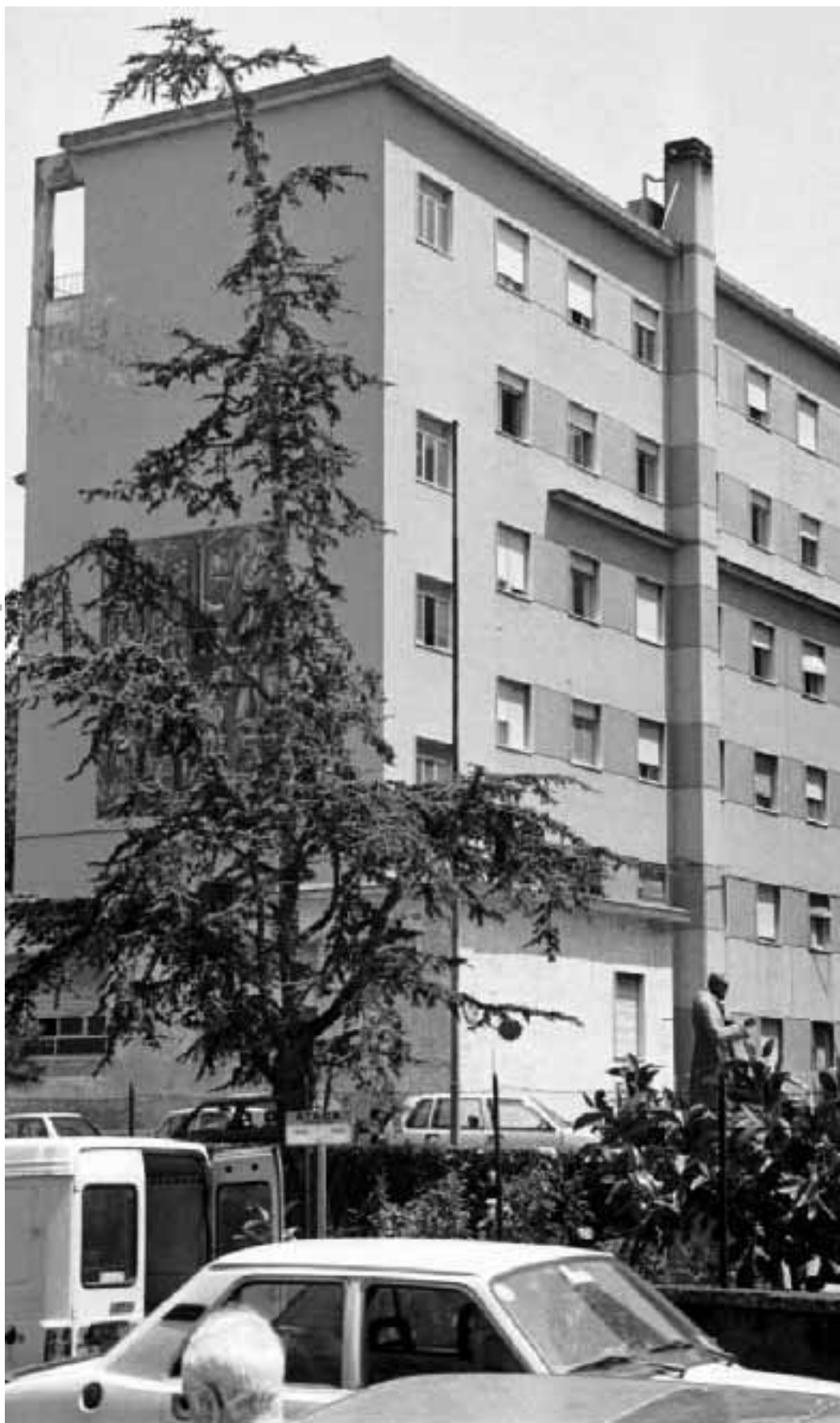
L'ospedale San Leonardo di Castellammare di Stabia
