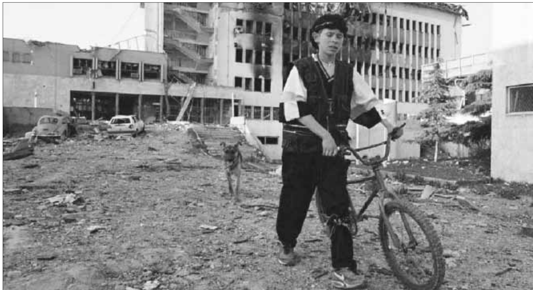
Un ragazzo tra le macerie dei palazzi colpiti dai raid aerei della Nato
