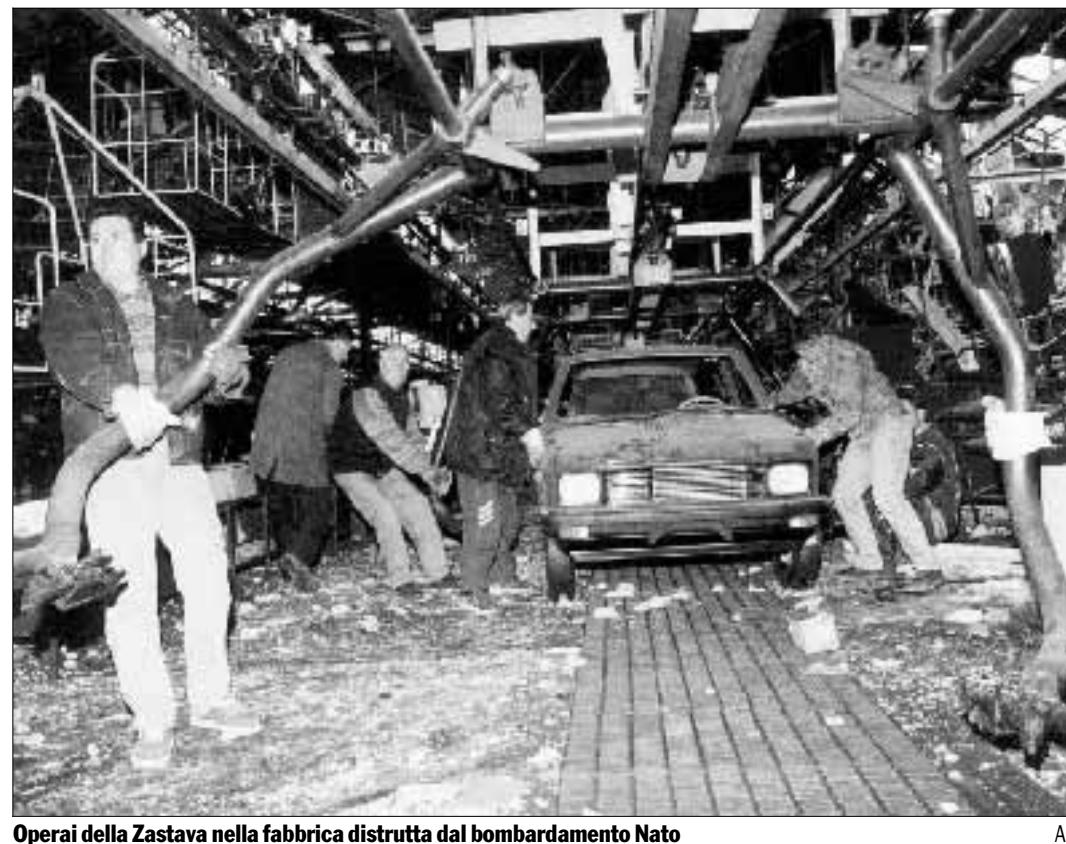
Operai della Zastava nella fabbrica distrutta dal bombardamento Nato
